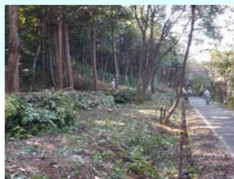
緩衝帯の整備
