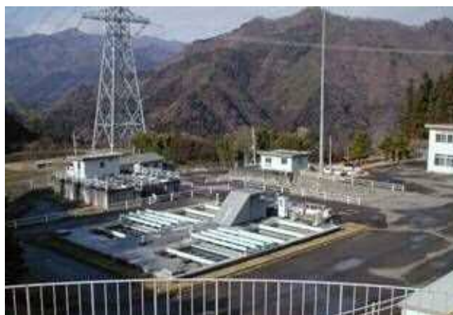
中之条上水道 三ノ原浄水場
