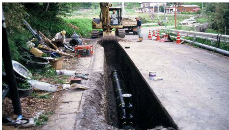
水道管布設工事の様子
