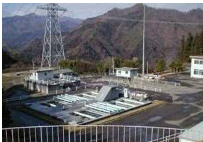
中之条上水道 三ノ原浄水場
