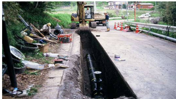
水道管布設工事の様子
