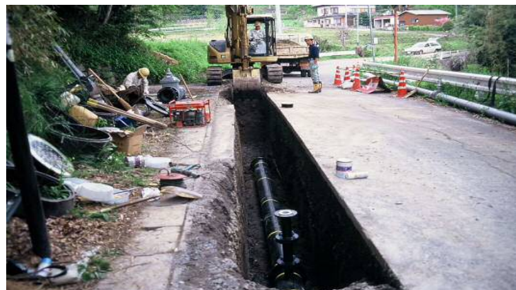
水道管布設工事の様子
