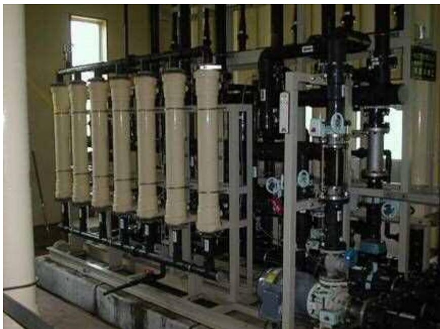
クリプトスポリジウム対策に優れた効果のある有笠浄水場の膜ろ過設備
