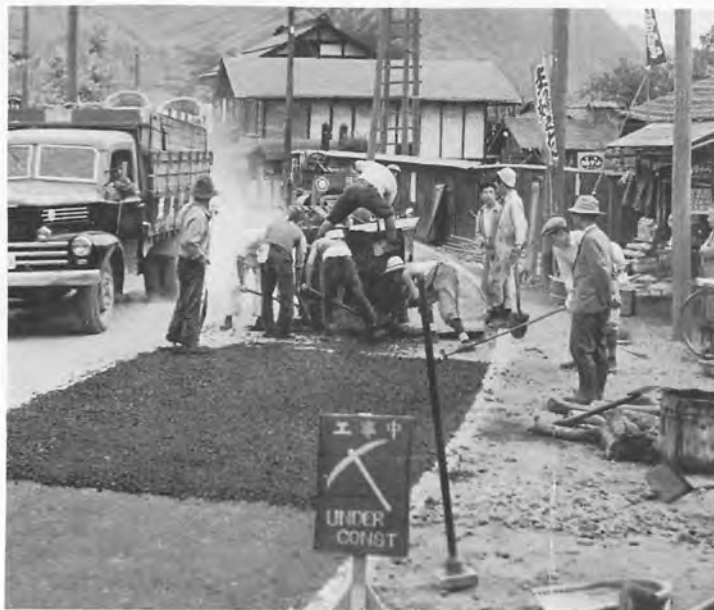
◀ 昭和二十七年 伊勢町地内舗装工事
