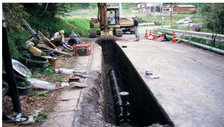
水道管布設工事の様子
