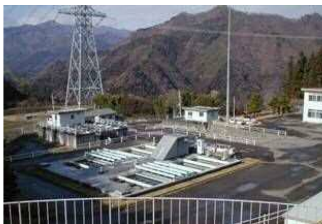
中之条上水道 三ノ原浄水場
