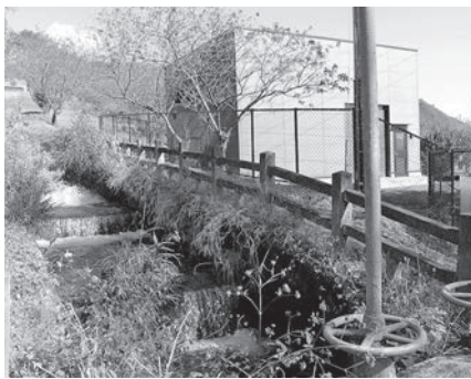
美野原用水を利用した小水力発電所
