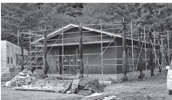
建設中の『尻焼温泉弁天の湯』
