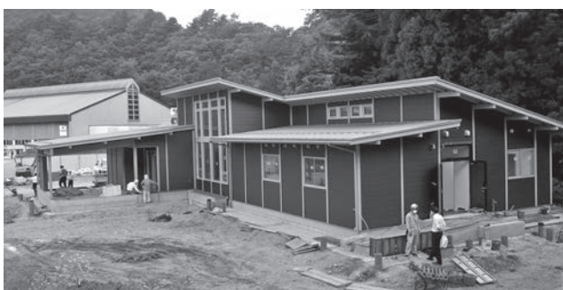
建設工事が進む六合診療所
