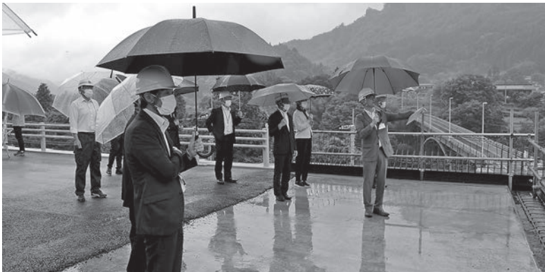
上信自動車道の工事現場（東吾妻町厚田）で、工事の進捗状況を説明いただきました。
