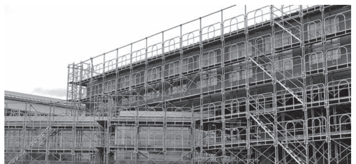
ツインプラザ図書館棟の改修工事を行います
