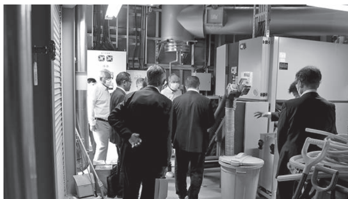
役場庁舎横のバイオマスボイラー施設で六価クロム関係について説明を受けました。
