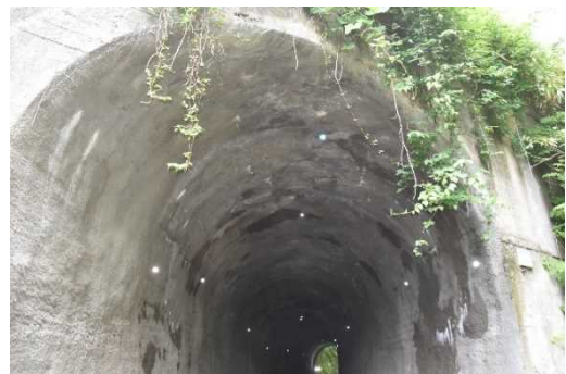
写真-2.2 愛宕第一隧道 (坑内状況 吹付コンクリート)
