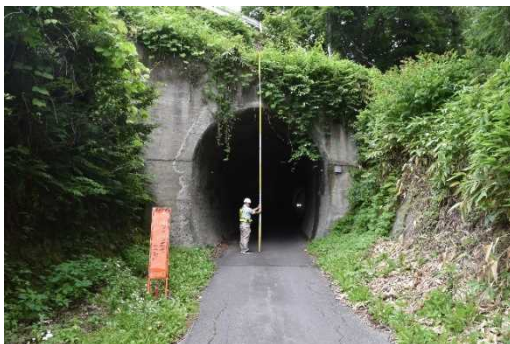
写真-2.1 愛宕第一隧道 (起点側入り口)
