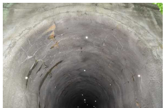
写真-2.4 愛宕第二隧道 (坑内状況 吹付コンクリート)
