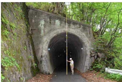
写真-2.3 愛宕第二隧道 (起点側入り口)
