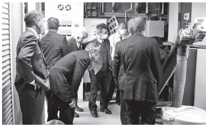
原因となる箇所やコーティング処理の状況を確認しました。
