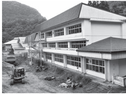
解体される旧入山小と体育館
