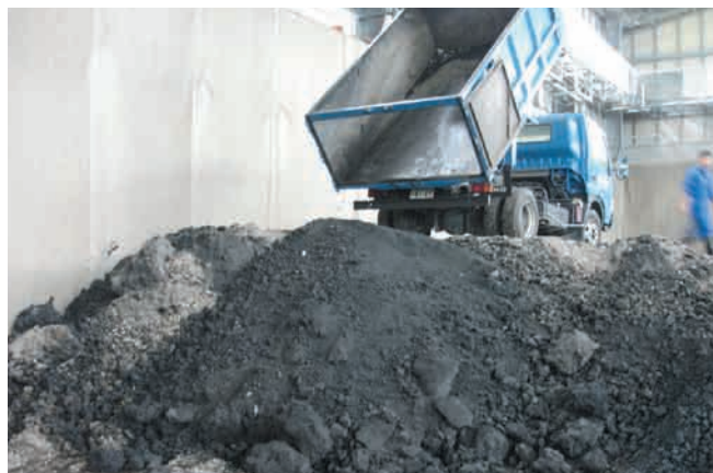
最終処分場での焼却灰の埋め立ての様子
