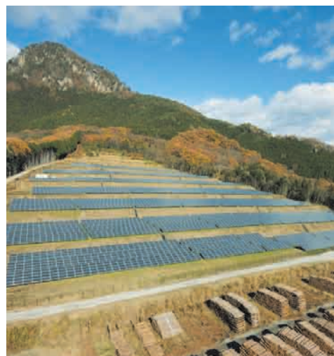
沢渡温泉第1太陽光発電所
