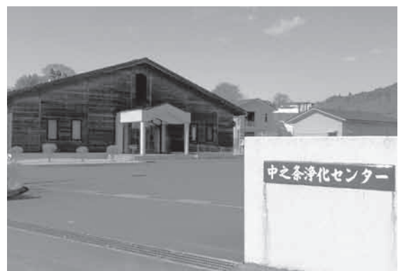
処理場「中之条浄化センター」（大字伊勢町地内）
