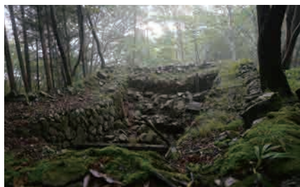
荒船・東谷風穴蚕種貯蔵所跡 (国指定史跡)
