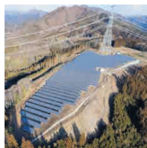
沢渡温泉第2太陽光発電所
