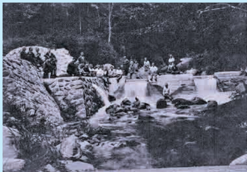
取水堰完成時
