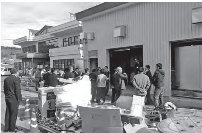
木質バイオマスボイラーの工事現場（中之条町役場）
