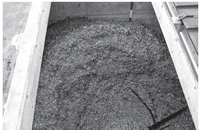
バイオマスボイラーの木材チップ（役場）
