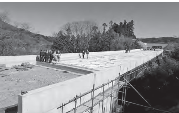
現在工事中の吾妻西バイパスの上信万木沢橋 (東吾妻町三島地区)
